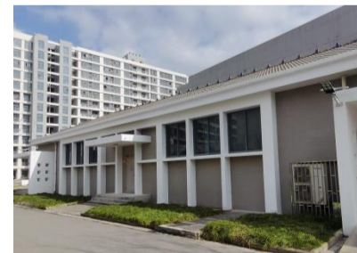
(高园校区三号变电所外墙翻新)
